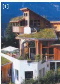
Abbildungen: [1] Begrüntes Flachdach zum Schutz von UV; [2] Sonneneinstrahlung; [3] Flachdach ungeschützt den UV-Strahlen ausgesetzt
