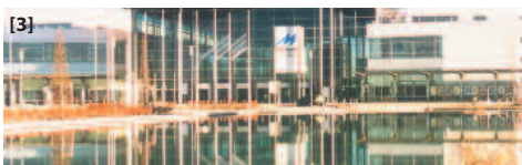
Abbildungen: [1] Klimaanlage auf Flachdach; [2] Versprödung von Dachbahnen; [3] Abgedichteter Messeteich München
