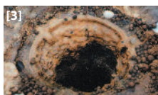
Abbildungen: [1] Materialversagen unter Kies; [2] Minderwertiger Mörtel; [3] Versinterung in Dachabläufen
