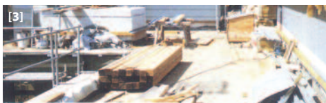
Abbildungen: [1] Spenglerarbeiten; [2] Dachpappennagel; [3] Flachdach als Lagerplatz
