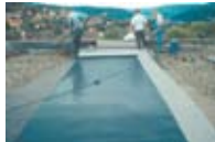
Verlegung und Verschweißung der neuen Dachabdichtungsbahnen
