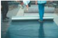
Trennlage auf alter Bitumenabdichtung
