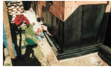
Flexible Vertikalabdichtung
