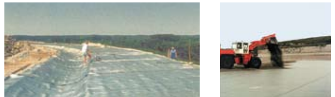
Deponie-Oberflächenabdichtung
