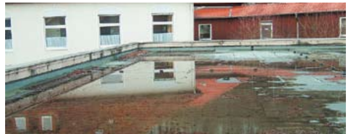
Vorher: Undichte Bitumendachfläche
