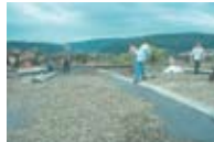
Wiederaufbringung der Auflast
