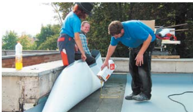
Verarbeitung von Dachbahnenkleber
