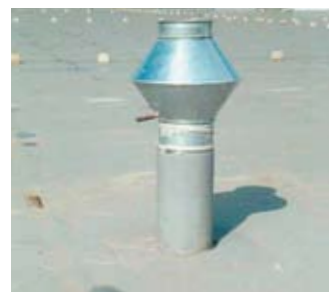
Anschluss an Dachdurchdringung
