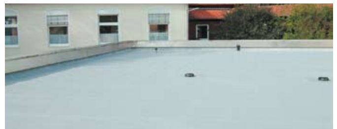
Nachher: Dachfläche mit Lucofin® saniert
