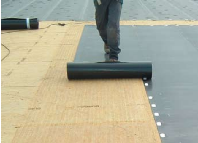
Verlegung nach Windlastberechnung exponierte Lage
