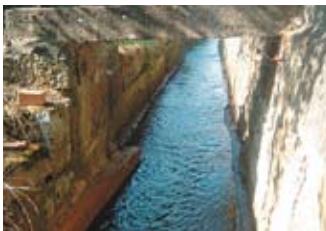
Ausdichtung einer Bachanlage
