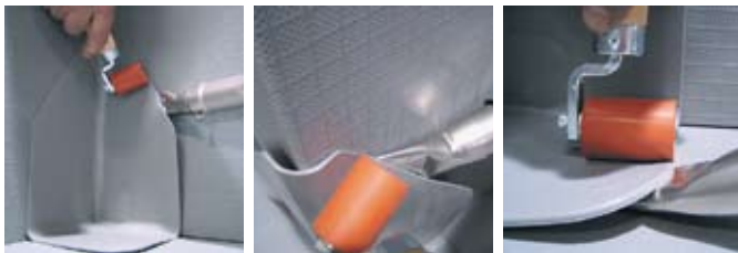
Verschweißen einer Formteilecke
