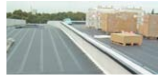
Mechanische Befestigung
