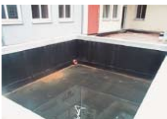
Abdichtung von Arbeitsfugen
