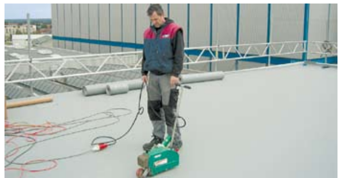
Arbeit mit dem Schweißautomaten
