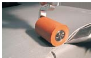
Verschweißen eines Traufenbleches
