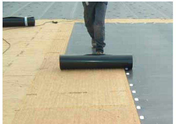
根据风荷载暴露计算铺设
