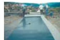
铺设和焊接新屋顶和密封膜
