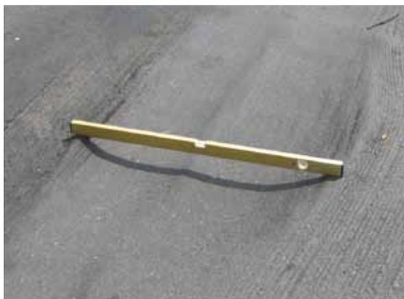
Formazione di solchi dovuta a traffico pesante ed elevati carichi per asse
