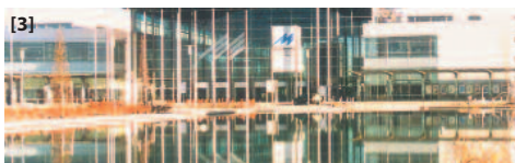
Afbeeldingen: [1] airco-installatie op plat dak; [2] verbrossing van dakbanen; [3] afgedichte vijver in München
