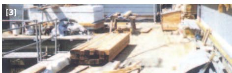
Afbeeldingen: [1] lood- en zinkwerkzaamheden; [2] asfaltnagel; [3] plat dak als opslagplaats
